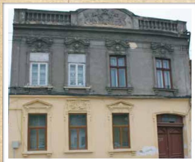
Reșița – The Mäerz House, today dwellings – 1875-1900 LMI (List of Historic Monuments) CS-II-m-B-10942 Reșița – Casa Mäerz, azi locuințe – 1875-1900 LMI (Lista Monumentelor Istorice) CS-II-m-B-10942 Reșița – Kuća Mäerz, danas kuće za stanovanje – 1875-1900 SSK (Spisak spomenika kulture) CS-II-m-B-10942
