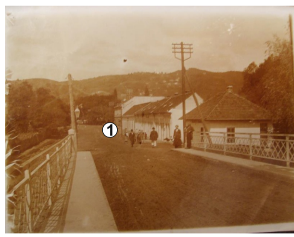
Refacere „Podul mare“ din beton cu balustrade metalice 1911 (ing. italian)
