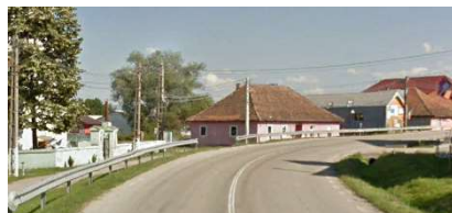
Centrul Ezerișului cu taluz și parapet la DN
