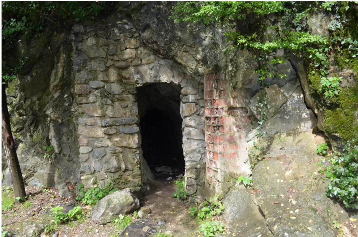
Pl. 26. Băile Herculane – Hotel Roman. Izvorul Hercule și urmele apeductului.
