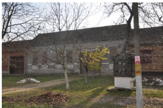
Strada principală din Vrâniș – fronturi și detalii
