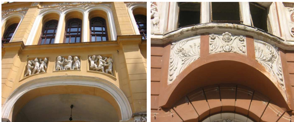
Detalii din stucatură pe fațadele Cazinoului și fostei Ospătării mari
